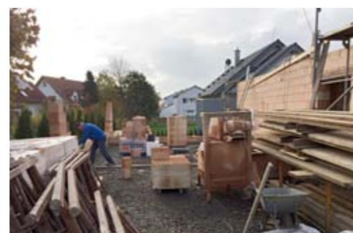
Baustelle in Mitterteich
